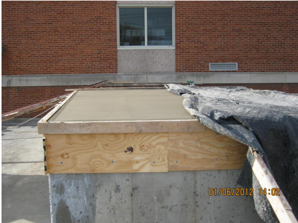
Trash Dock Floor Pour
